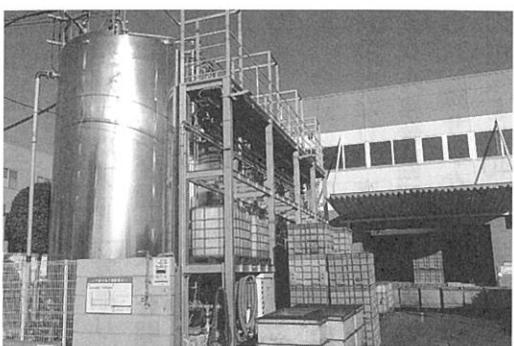
J-FECの工場。メタン発酵用に調整された原料が、左手前のタンクからバイオガス発電所にパイプで搬送される
