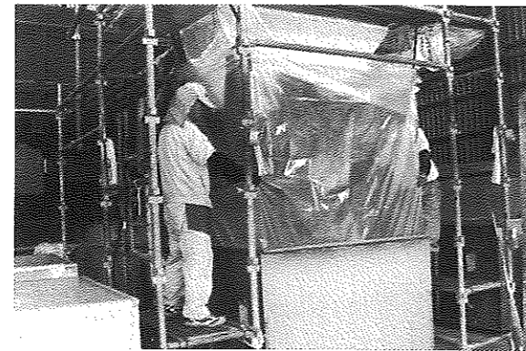
材料を攪拌後、ビニール袋に詰め、鉄の缶に入れて保管する
